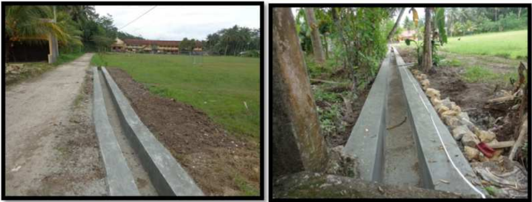
Gambar 3.11 Saluran Drainase dan Gorong-gorong Dalam Kondisi Baik Tahun 2017
